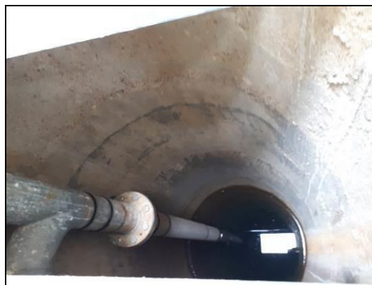
Intérieur du puits
