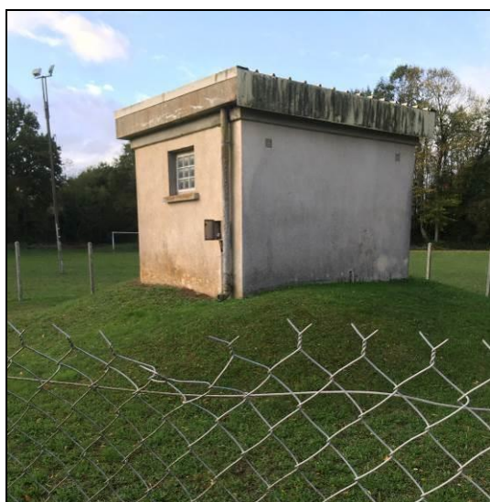
Local technique surélevé
