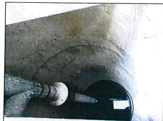
Intérieur du puits
