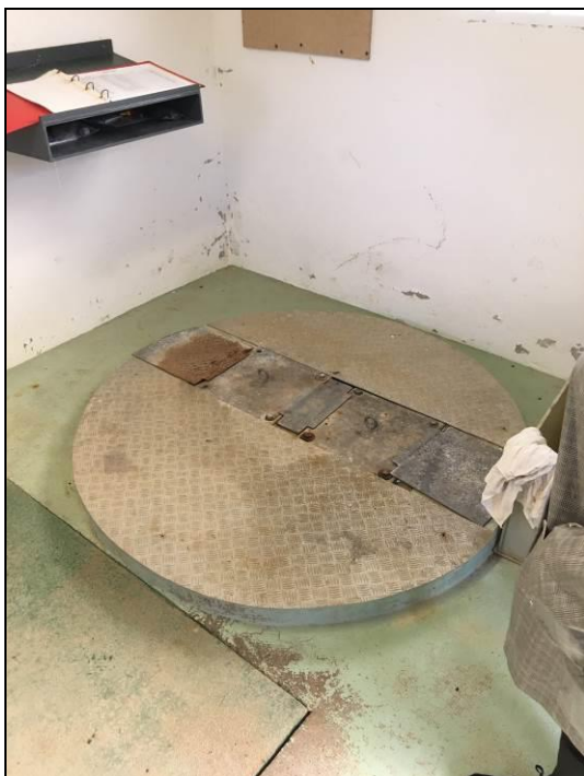
Tête du puits
